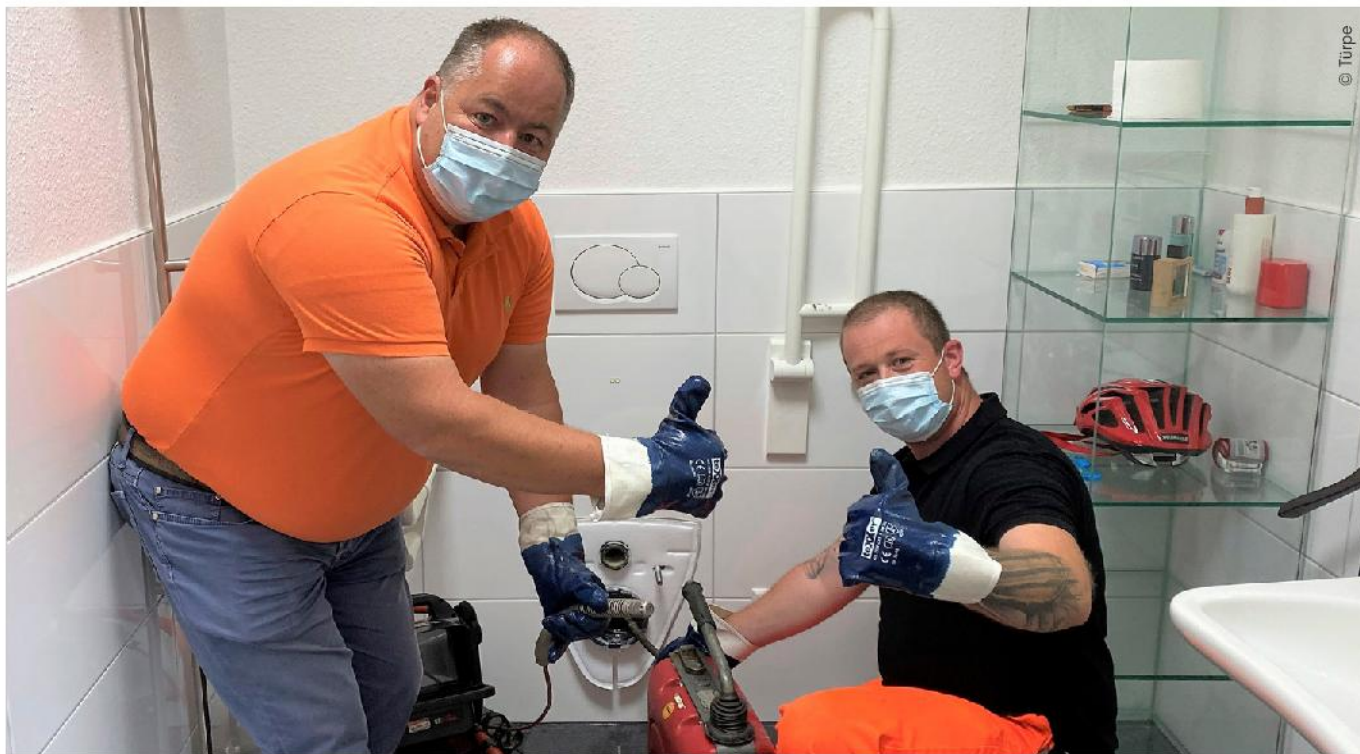
Geschäftsführer Olaf Türpe (links) und Service-Techniker Janos Bartar bei einem Rohrreinigungseinsatz mit TV-Kamera bei einem verstopften Toilettenabfluss.
