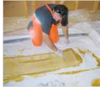
Das Harz wird gemischt und auf das Trägermaterial (Glasfasergewebe) aufgetragen.
