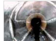
Einragende Dichtung
