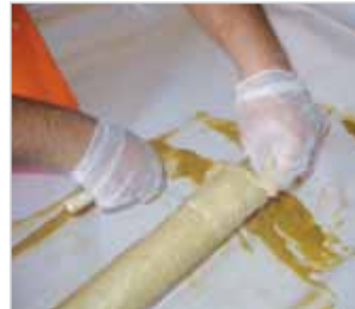
Anschließend wird das getränkte Material auf einen sog. Packer gewickelt.
